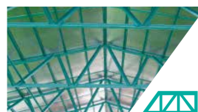
Hệ kèo mái tôn
